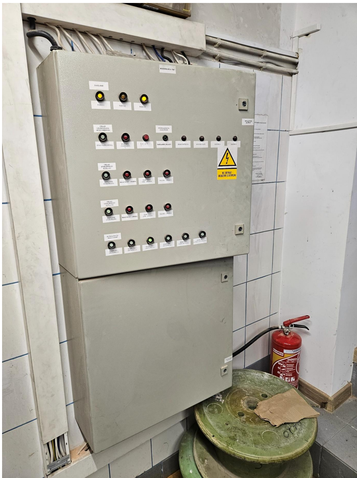
Rozdzielnia elektryczna do demontażu (w tym samym miejscu montaż nowej rozdzielnic elektrycznej dla kotłowni gazowej)
