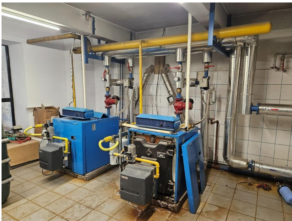
Kotłowy gazowe istniejące do demontażu i utylizacji
