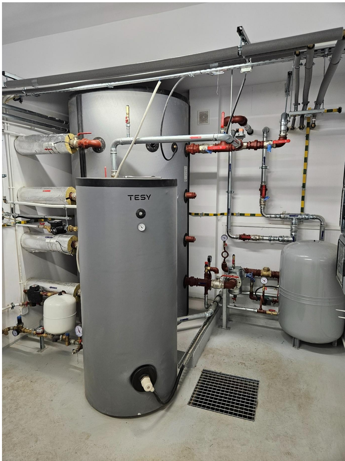
Podłączenie kaskady kotłów do bufora C.O. – bufor o pojemności 2000 litrów
