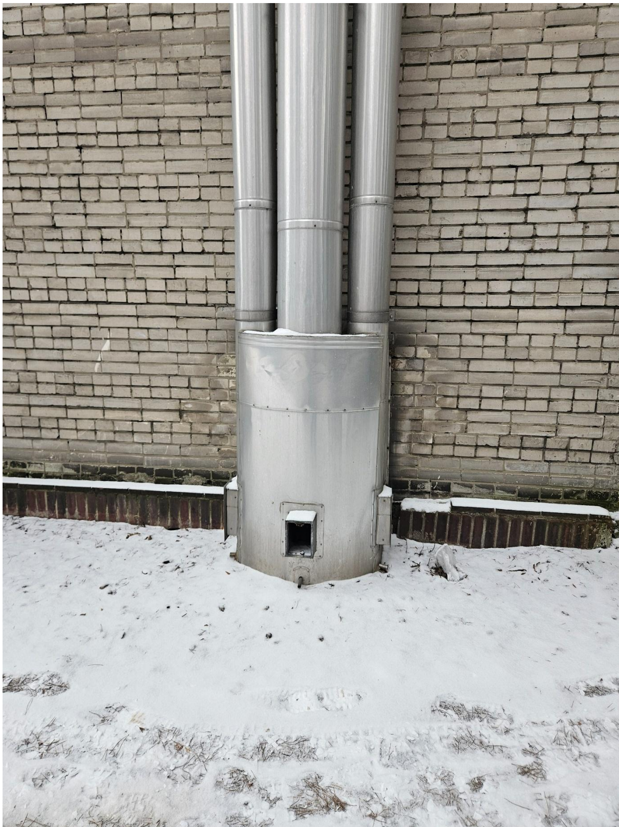
Komin zewnętrzny – do wymiany
