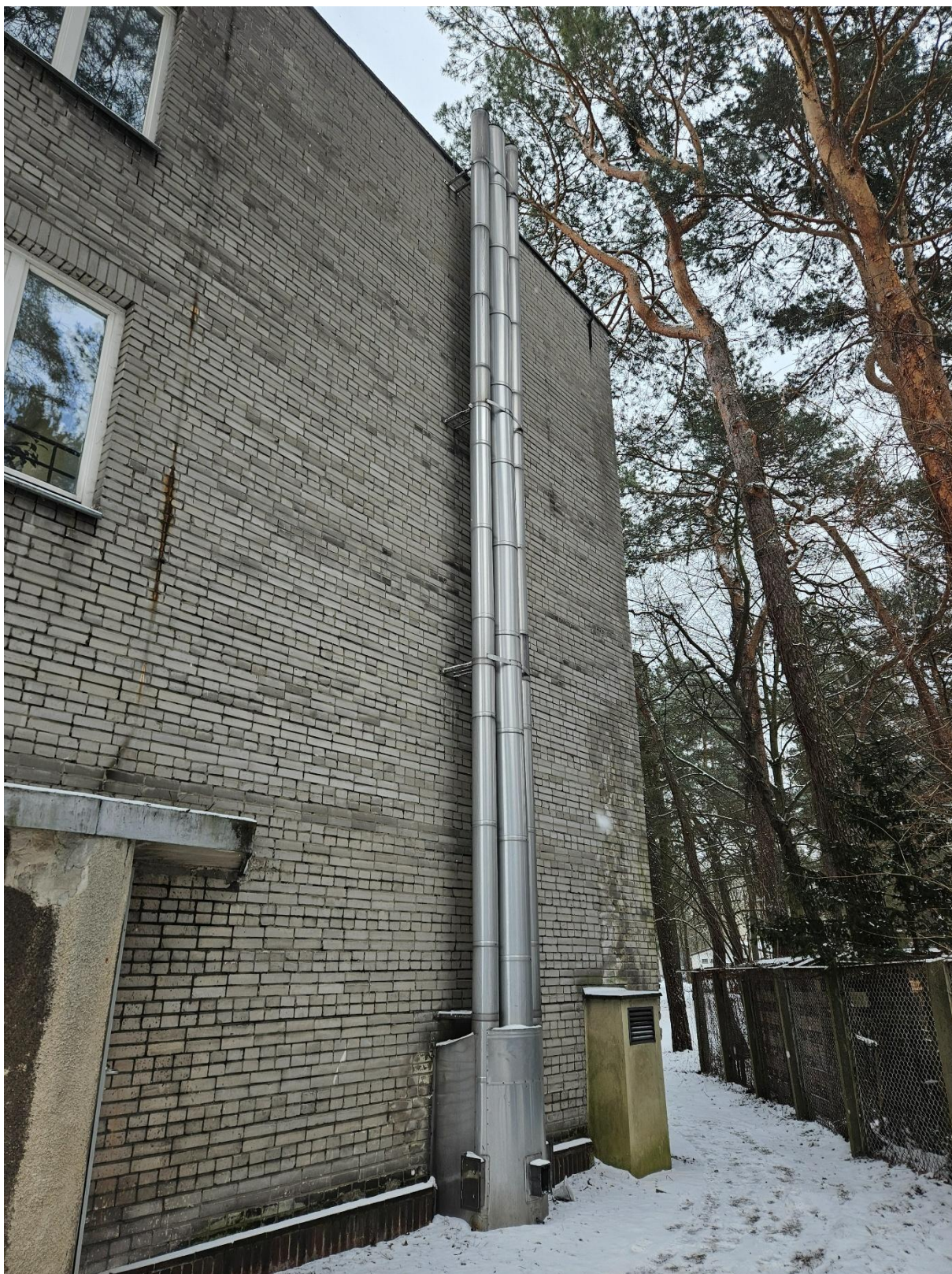
Komin zewnętrzny – do wymiany
